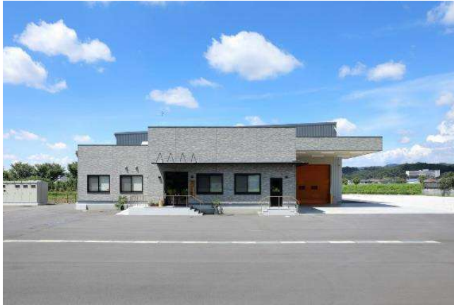
本社 睦実工場
